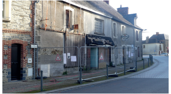
Le bâtiment de l'ancienne graineterie mis en sécurité
